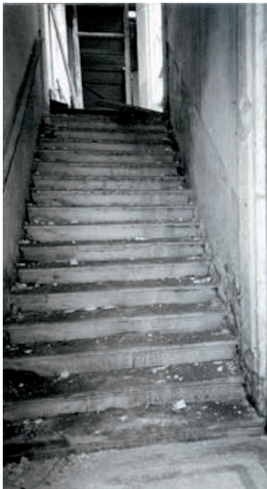
Particolare della scala principale: prima rampa (stato di fatto, 1987) (Foto Lucio Candolini)
